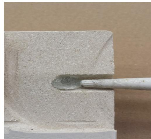
Montieren Sie die Kachel wie auf dem Bild rechts. Die Kacheln werden nacheinander in fortlaufender Nummerierung montiert.
