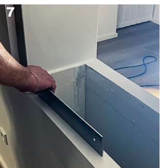
7 Alle kryds mål skal være i vinkel / All cross-measures must be at an angle.
