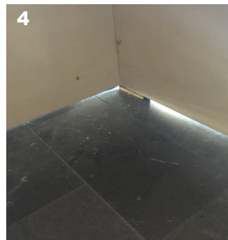
4 Væggen er ikke hermetisk lukket for nederen, der kan komme træk / The wall is not hermetically sealed at the bottom, which can cause drafts.
