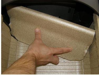
Retirez la chicane de fumée en la soulevant et en l'inclinant vers l'arrière. Sortez la chicane de fumée.
