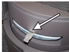
Le cendrier est situé sous la grille de criblage et vidé au besoin.
