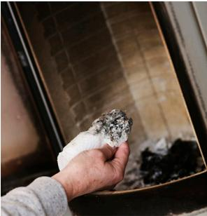
Reinigen Sie das Innere der Scheibe mit einem feuchten Tuch, dass Sie in die ganz feine Asche im Ofen eingetaucht haben.
