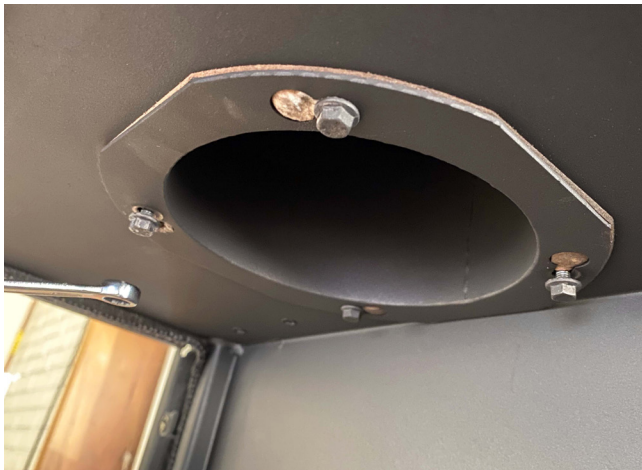
1. Desserrez deux des boulons en diagonale.
